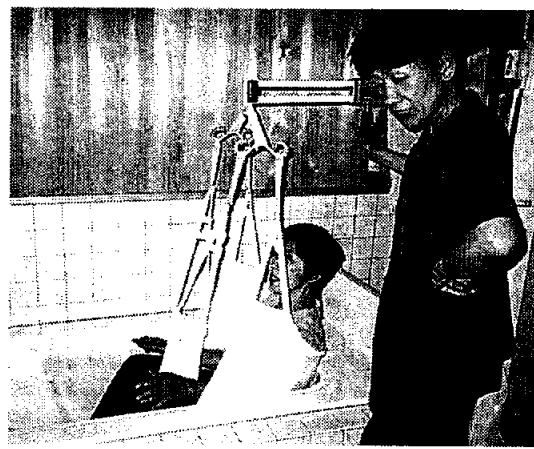
Mさん宅での浴室に設置されたリフト。右端に見える支柱がリフトを支える
