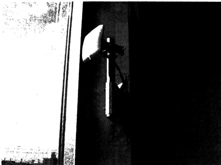
図 6 使用した指向性アンテナの取り付け例（中央病院 師長当直室側）
