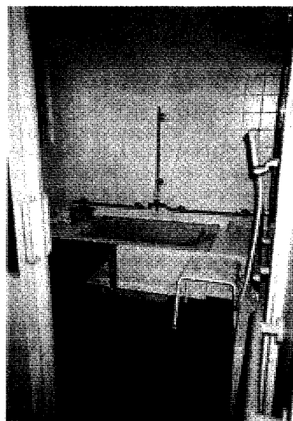
写真② 金沢バリアフリーモデルハウス浴室—手摺の位置、浴槽両側の空間、腰掛け椅子の工夫に注目
