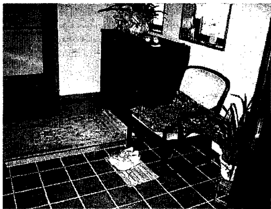
ひざの屈伸が不都合な人のため玄関に丈夫なすべり材を用意。げた箱、奥の飾り棚を手すり代わりにして内へ移動できる
