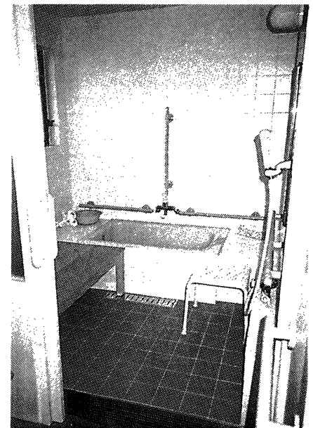
写真② 金沢バリアフリーモデルハウス浴室—手摺りの位置、浴槽両側の空間、腰掛け椅子の工夫に注目
